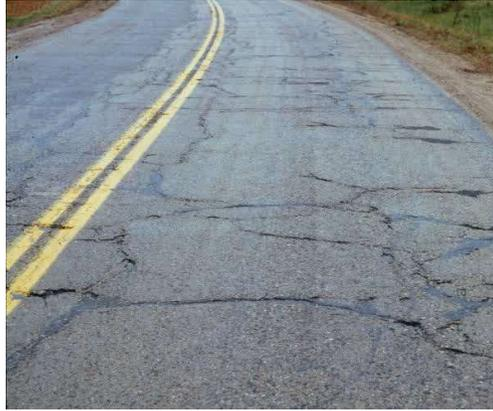
Gambar 2.11 Retak refleksi (*reflection cracks*)
