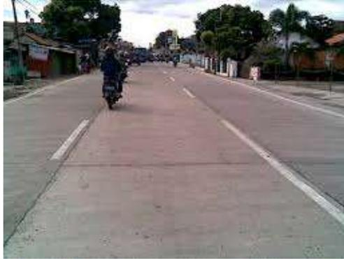
Gambar 2.13 Retak sambungan pelebaran jalan (*widenning cracks*)
