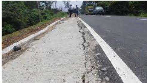
Gambar 2.10 Retak sambungan bahu dan perkerasan (*edge joint cracks*)
