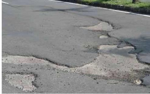
Gambar 2.21 Pengelupasan lapisan permukaan (*stripping*)
