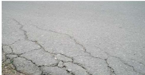
Gambar 2.9 Retak pinggir (*edge cracks*)
