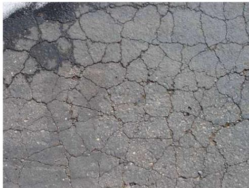
Gambar 2.14 Retak susut (*shrinkage cracks*)
