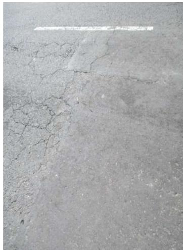
Gambar 2.7 Retak halus (*hair cracking*)
