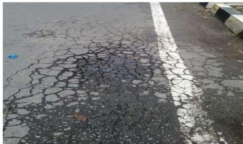
Gambar 2.8 Retak kulit buaya (*alligator cracks*)
