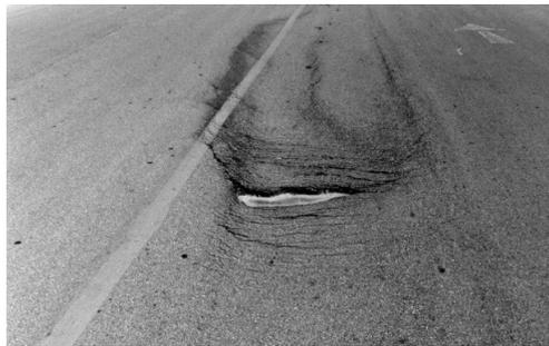
Gambar 2.15 Retak selip (*slippage cracks*)
