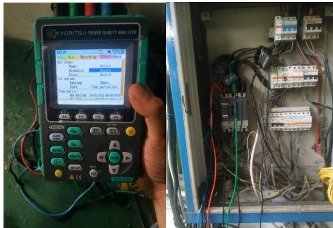
Gambar 3.4 Proses Pengukuran
