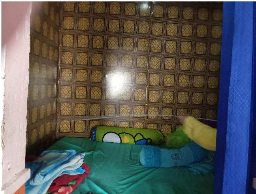
Kamar yang tidak memiliki ventilasi udara
