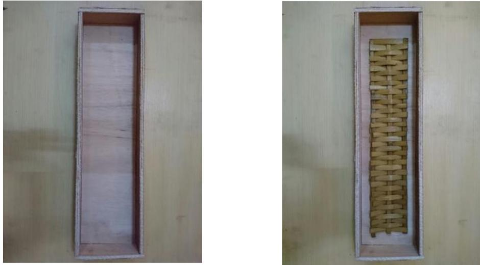
Gambar 4. Persiapan Cetakan Beton
