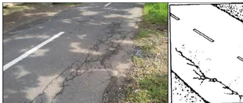
Gambar **Error! No text of specified style in document.**8 Retak Pinggir (*Edge Crack*)
