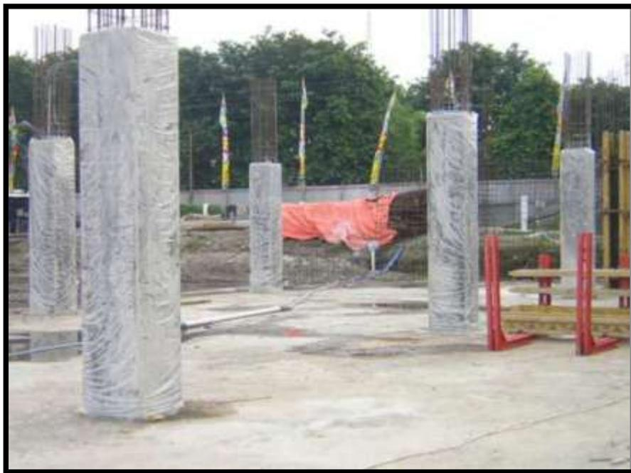
**Gambar 2.16** Perawatan dengan Menggunakan Penutup Plastik Di Lapangan
