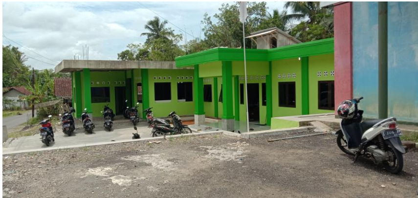
Gambar 3. 4 Kantor Desa Cogreg (Sumber: Dokumentasi pribadi, 2022)
