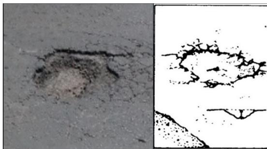
Gambar 2.21 Lubang (*Potholes*)
